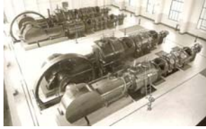
Compresor de Pistón Accionado por Máquina de Vapor (NEA 1935)
